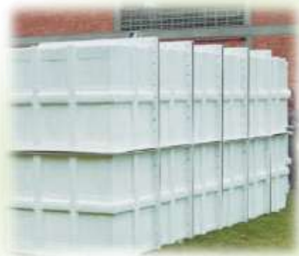
Tanque por módulos rectangular contraincendios, hidroeléctrica La Miel.
